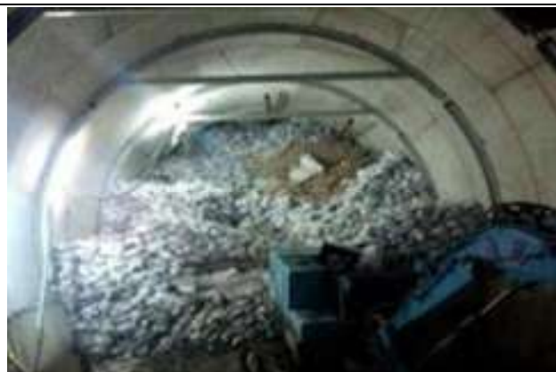
潛盾洞道堆置砂包情形
