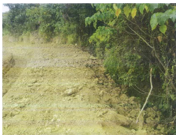
土石回填淤塞既有水路通道
