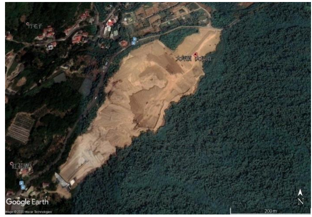
2018/11/13 google earth 歷史空拍照片 (當時開挖情形)
