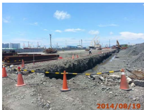
集油坑、溝設置
