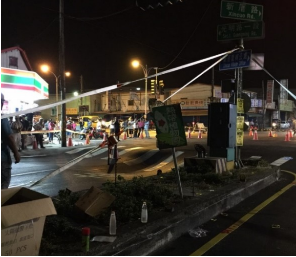
104 年 10 月 5 日夜間路面塌陷情形
