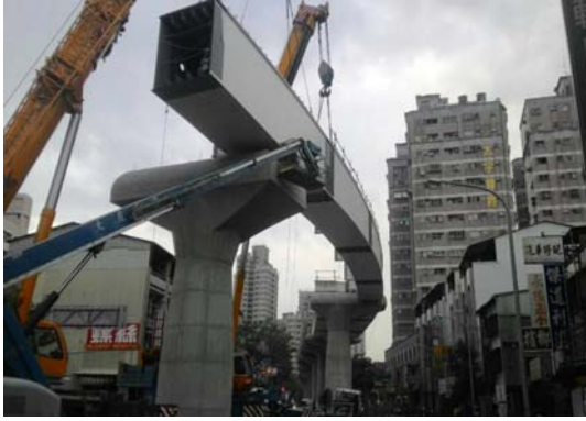
鋼箱樑吊裝作業
