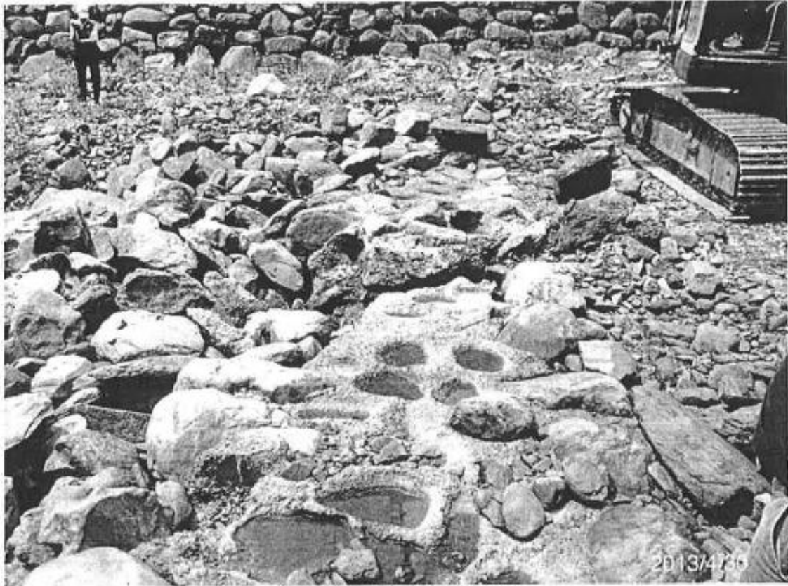
第 16 號固床工開挖情況
