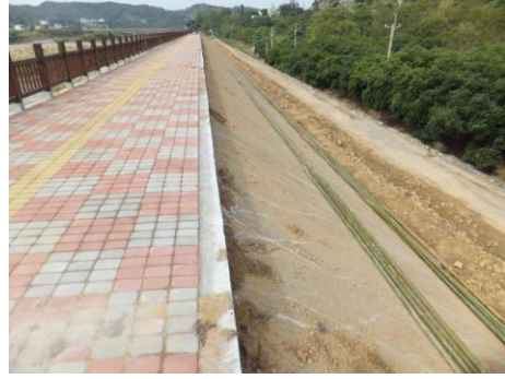
圖 3-2 斜撐角鋼上方置綠竹 (施工中)
