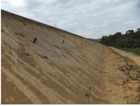
圖 3-1 堤後坡設置斜撐角鋼(施工中)
