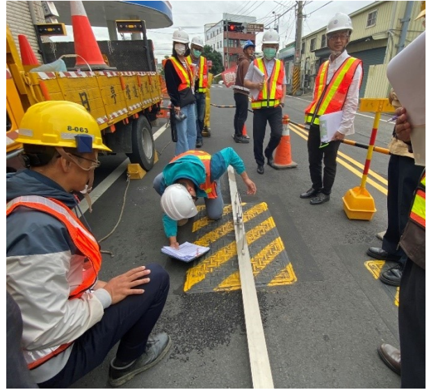
孔蓋銜接處檢視
