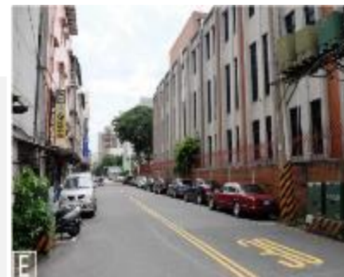
E. 西側為4層鄰房，11米雙行道；有停車格臨近工區圍牆，拆除階段須注意保護
