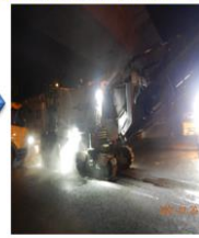
使用刨除機刨除作業
